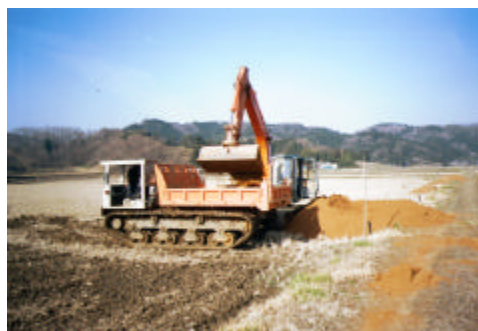
（面積A = 15.03haに、土量V = 1,672m³を運搬した10tダンプキャリア）
